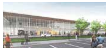
完成間近の空港ターミナルビル
